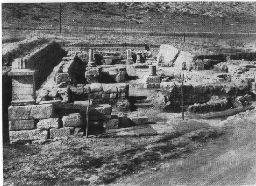
Εἰκ. 25. Αὐλὶς. Ἐποψὶς τοῦ ναοῦ τῆς Αὐλιδαίας Ἀρτέμιδος μετὰ τὴν ἀποκατάστασίν του.
