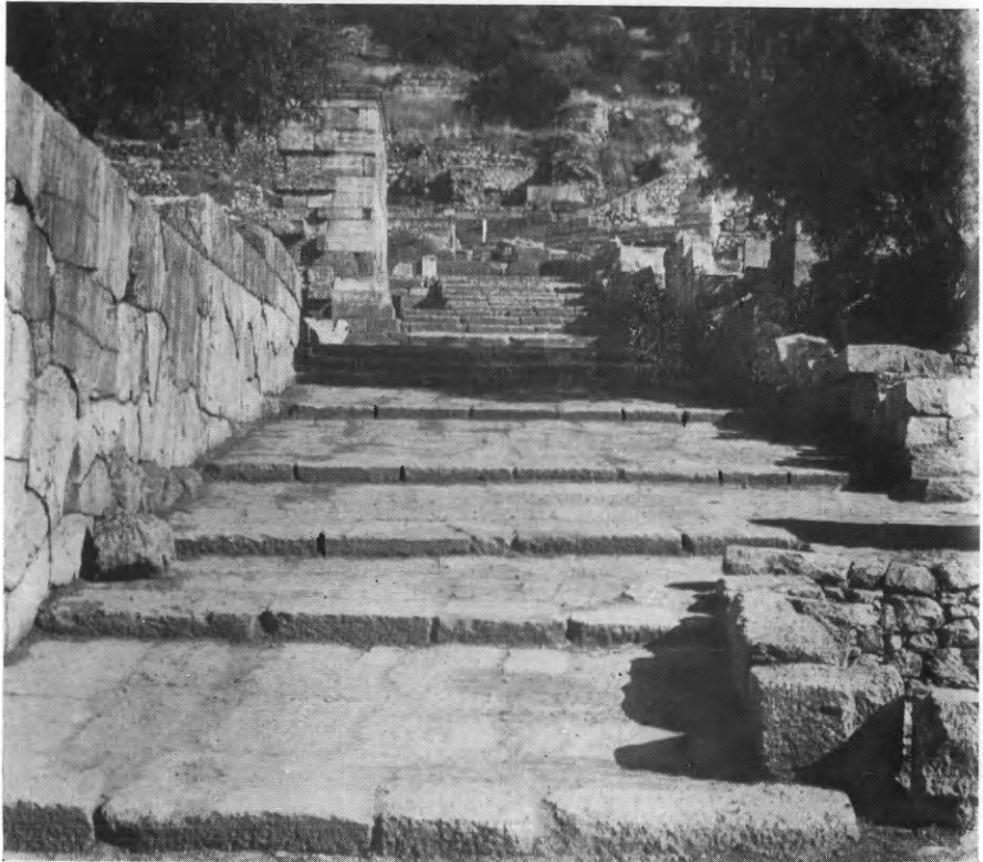
Εἰκ. 191. Δελφοί. Ἡ ἱερὰ πομπικὴ ὁδὸς μετὰ τὰς ἐργασίας τακτοποιήσεως αὐτῆς ὑπὸ τῆς Ὑπηρεσίας Ἀναστηλώσεως.
