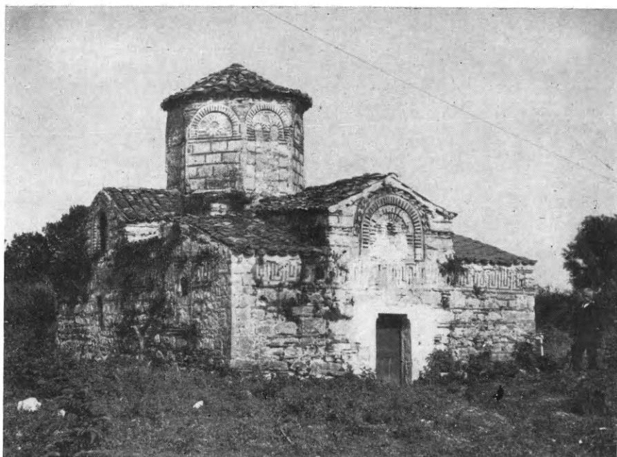
Εἰκ. 198. Ὁ Ἅγ. Νικόλαος τῆς Ροδιᾶς πρὸ τῶν ἐργασιῶν ἀναστηλώσεως.
