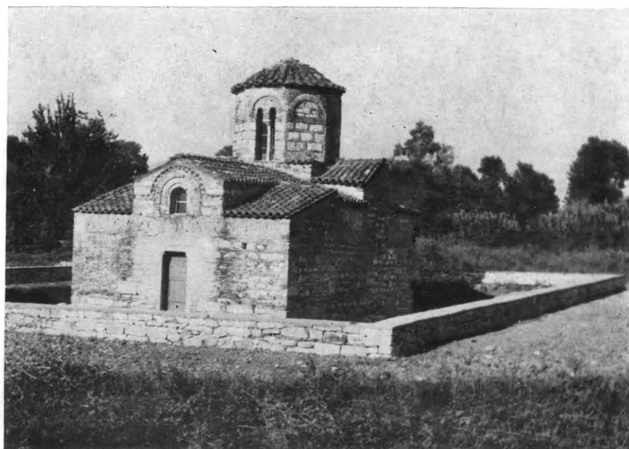
Εἰκ. 199. Ὁ Ἅγ. Νικόλαος τῆς Ροδιᾶς μετὰ τὰς ἐργασίας ἀναστηλώσεως.
