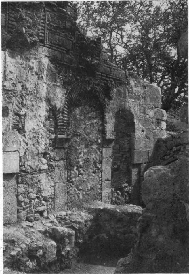
Εἰκ. 97. Τὸ τρίβηλον εἰσόδου τῆς Τραπέζης, ὡς ἀπεκαλύφθη μετὰ τὴν κατεδάφισιν τῶν μεταγενεστέρων κτισμάτων.
