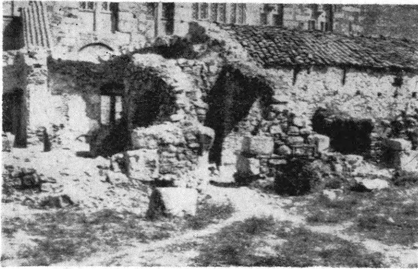
Είκ. 95. Ἡ Τράπεζα τῆς Μονῆς Ὁσίου Λουκά μετὰ τὸν ἐπὶ κατοχῆς βομβαρδισμόν αὐτῆς.
