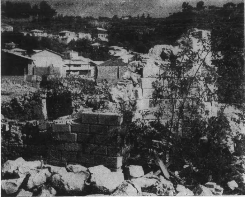
Είχ. 120. Όψις τοῦ ναοῦ τῆς Παναγίας τῶν Ἀγγέλων τῆς Ζακύνθου εὐθύς μετὰ τοὺς σεισμοὺς τοῦ 1953.
