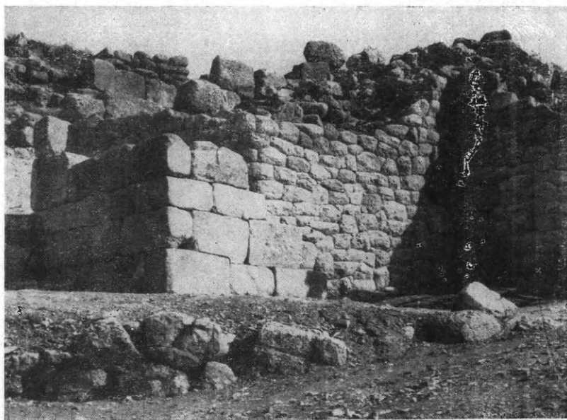
Είχ. 71. Τὸ νοτίως τῆς πύλης τῶν λεαινῶν ἀποκαλυφθὲν τμημα τοῦ τείχους τῶν Μυκηνῶν καὶ ὁ πρό αὐτοῦ ἀναστηλωθεὶς ὀρθογώνιος πύργος.
