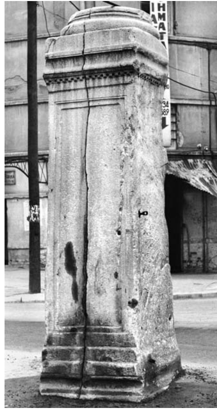
Εἰκ. 13. Τὸ βάθρο κίονα, βόρεια ὄψη (φωτ. τῆς ΙΣΤ' ΕΠΚΑ, 1975).
