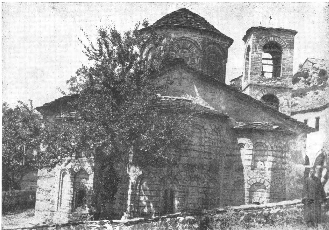
Εἰκ. 6. Ἄψις καὶ κόγχαι τῆς ἀνατολικῆς πλευρᾶς τοῦ Καθολικοῦ τῆς Ἱ. Μονῆς τοῦ Πυλαίου.
