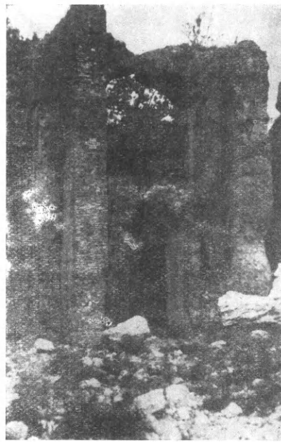
Εἰκ. 18. Ἐτερον τμήμα τῆς γεφύρας τοῦ ὕδραγωγείου, δι' ἧς διωχετεύετο τὸ ὕδωρ ἐκ τῆς ἀνατολικῆς εἰς τὴν δυτικὴν πλευράν τῆς χαράδρας τοῦ Λούρου.
