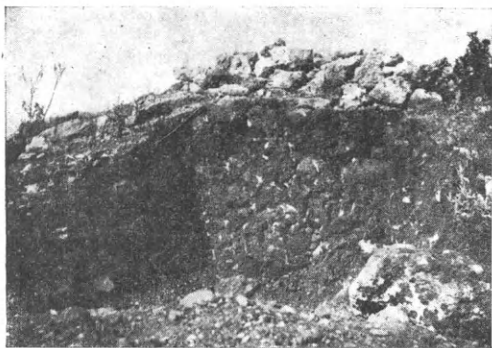
Εἰκ. 8. Τομὴ κωνοειδοῦς κτίσματος ἐπὶ λοφίσκου τεχνητοῦ δυτικῶς τοῦ ἰσοπεδωμένου ἀρχαίου ὑπαιθρίου χώρου (ἀβάτου;) τοῦ Σελλιοῦ.
