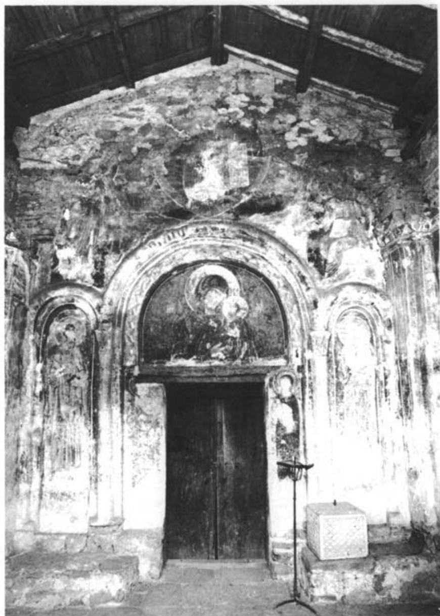
Fig. 6. L'ossuaire de Bačkovo. Le mur est du narthex avec les pilastres, porteurs des grands arcs.
