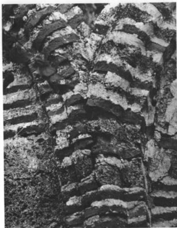
Fig. 5. L'ossuaire de Bačkovo. Jonction des arcs en briques et en briques et poros sur la façade nord.
