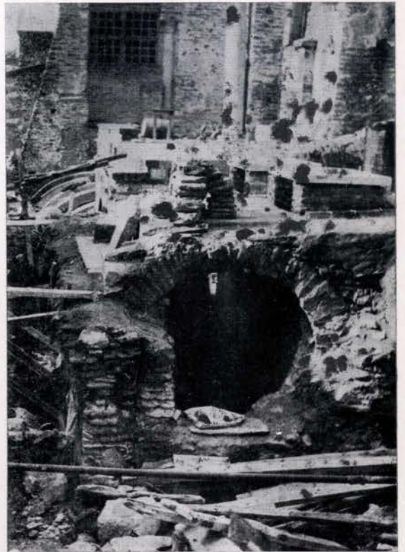
β. Ἡ εἰς δεξαμενὴν μετατραπεῖσα κλίμαξ τοῦ βορείου πτερυγίου. (σ. 138)
