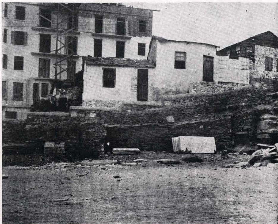
α. Λείψανα πλινθοκτίστων θόλων τῶν κερκίδων τοῦ Σταδίου δυτικῶς τῆς αὐλῆς τῆς βασιλικῆς. (σ. 36)
