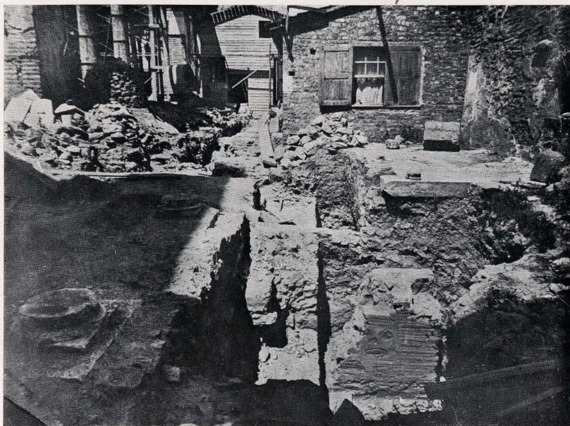
β. Θεμέλια τοίχων του ρωμαϊκού λουτρού κατά μήκος του στυλοβάτου της νοτίας δευτέρας κινοσοιχίας της βασιλικής. (σ. 39, 96)
