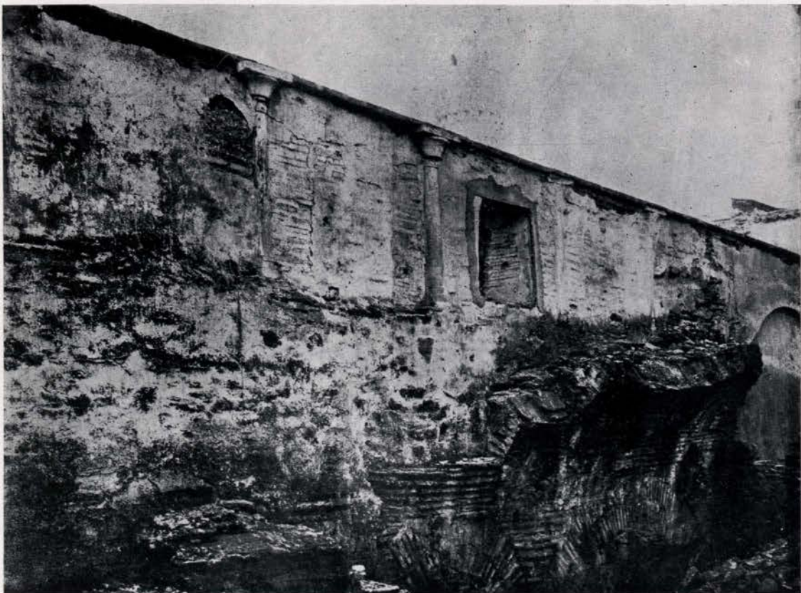
β. Τὸ ἄνω τμήμα τοῦ αὐτοῦ τοίχου ἐκ τοῦ ἐξωτερικοῦ μετὰ λειψάνων θόλου ὑπεράνω τῆς πύλης. (σ. 81, 135)
