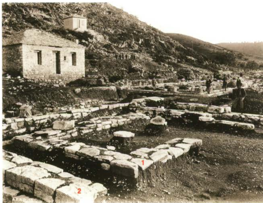
136 Ὁ ναὸς τῆς Ἀρτέμιδος(ι) μετὰ ἀπὸ τὴν πρώτη ἀνασκαφή ἀπὸ ΒΔ. 1899: 1 παλαιότερο κτίσμα, 2 βόρειος τοίχος τοῦ ναοῦ.
