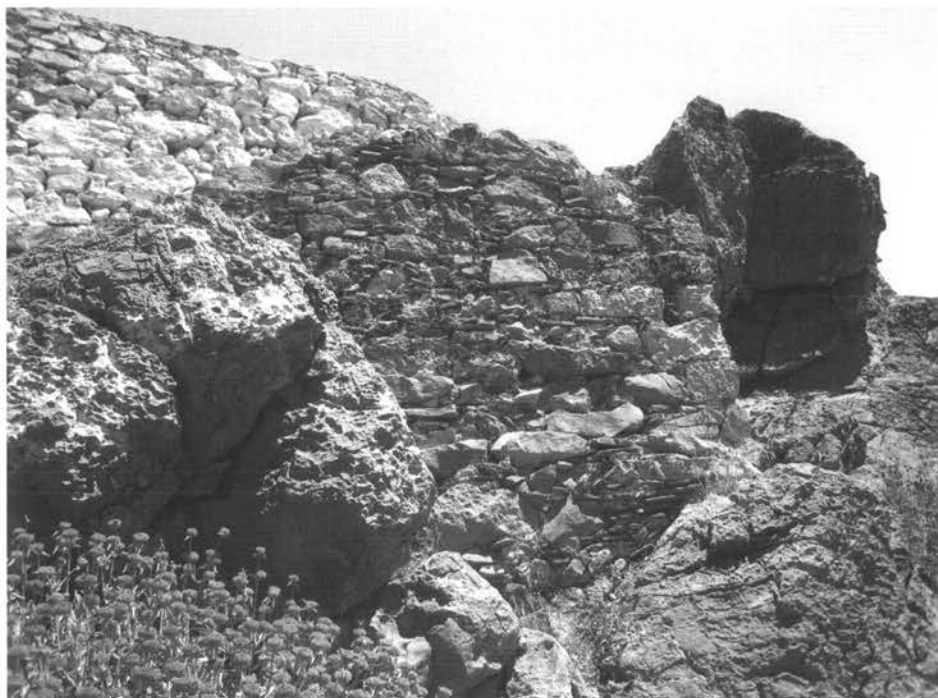
Είκ. 5. Τμήμα ἀναλημματικοῦ τοῖχου στὸ Ἄνδηρο 3 (λήμη ἀπὸ Νότο).
