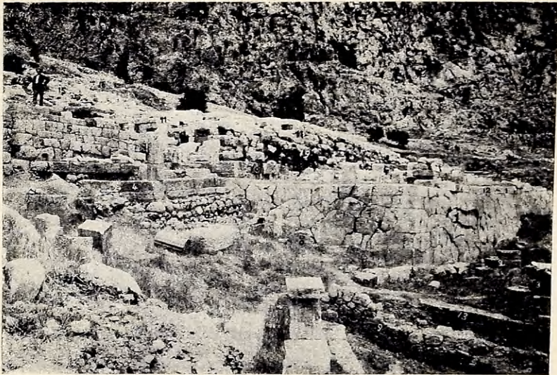
Εἰκ. 20. Ὅψεις ἀπὸ δυσμῶν. Ἐμπρὸς δεξιὰ (9) ὁ παλαιὸς περιβόλος. (13) παλαιὸν ὕδραγωγεῖον. (2) γωνία πωρίνου κτιρίου τμηθεῖσα ὑπὸ τοῦ πολυγωνικοῦ ἀναλήμματος ἔχοντος ἄνω εὐθυγράμους δόμους πωρίνους (12) τὸ δὲ ἐν τῇ γῆ ποτὲ κρυπτὸν ταπεινὸν μέρος (8) ἀδρότερον εἰργασμένον. Ὑπεράνω εἶνε (19) τὰ κρηπιδώματα τοῦ ναοῦ. Ἀριστερὰ (4.5) πώρινα λείψανα δύο καλυφθέντων μετὰ τὸ 548 θησαυρῶν πιθανῶς.
