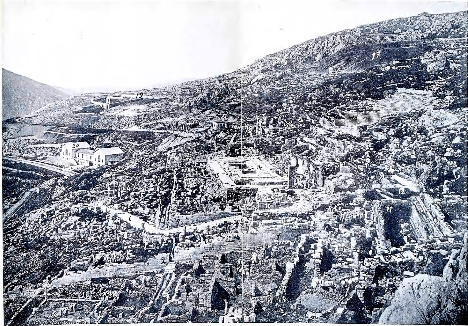
Εικ. 35. Ὁψεις τῶν ἑρείπων τοῦ τεμένους Ἀπόλλωνος ἀπ' ἀνατολῶν. (1) Ἰσοδομικὸν μέρος τοῦ περιβόλου. (2) πύλη Γ («πυλὶς» σ. 51). (3) ὁ θησαυρὸς τῶν Κνιδίων (σ. 32) (4) ὁ θησαυρὸς τῶν Ἀθηναίων ἀνακτιζόμενος (σ. 37). (5) ἡ πέτρα τῆς Σιβύλλης (σ. 41). (6) ἡ ἱερὰ ὁδὸς πλακόστρωτος. (7) ἡ κλίμαξ τῆς Ἄλω. (σ. 48, 46). (8) ἡ στοὰ τῶν Ἀθηναίων (σ. 42 ἐξ.). (9) ἡ ἀνατολικὴ πλευρὰ τοῦ μεγάλου πολυγωνικοῦ τοίχου («τὸ ἀνάλημμα τὸ Ἐξωθεν» σ. 42, 68). (10) ὁ μέγας βωμὸς (σ. 52). (11) ἡ στοὰ τοῦ Ἀττάλου μεταβεβλημένη εἰς δεξαμενὴν τέμνει τὸν περιβόλον (σ. 56). (12) τὸ τέμενος τοῦ Νεοπτολέμου (σ. 57). (13) τὰ ἱστέγασον (σ. 60, 57, 70, 72). (14) ὁ ναὸς τοῦ Ἀπόλλωνος (σ. 62). (15) ἡ γραμμὴ τῶν νοτίων κρηπίδων αὐτοῦ (σ. 68). (16) τὸ θέατρον (σ. 73). (17) τὰ ἐκ τοῦ σταδίου γώματα (σ. 79). (18) ἡ στοὰ τοῦ Εὐμένους (σ. 79). (19) τὸ σημερινὸν νεκροταφεῖον τοῦ Προφήτου Ἥλια (πάλαι Πυλαία, Θυαί, Θύστιον σ. 81). (20) τὸ Μουσεῖον.
