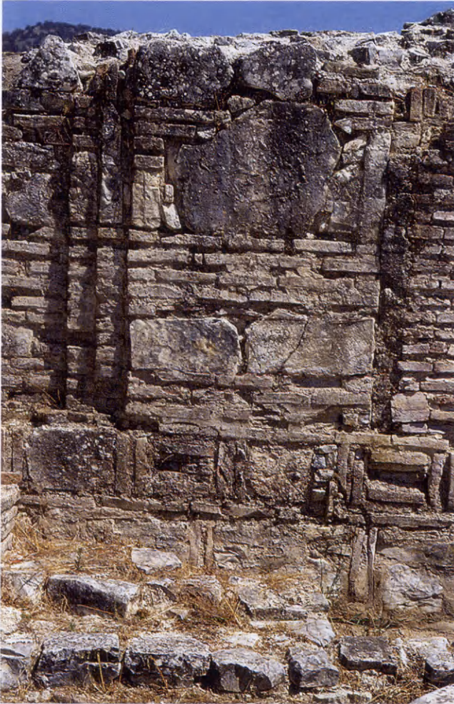
10. Τμήμα της δυτικής πλευράς του νάρθηκος από Δυσμών. Ἀριστερὰ καὶ δεξιὰ τυφλὰ ἀψιδώματα. Τὸ δεξιὸ διασώζει τὸ γέμισμα με τοῦβλα γιὰ νὰ σχηματισθεῖ ἐνιαία ἐπιφάνεια ποὺ νὰ διακοσμηθεῖ με τοιχογραφίες.
