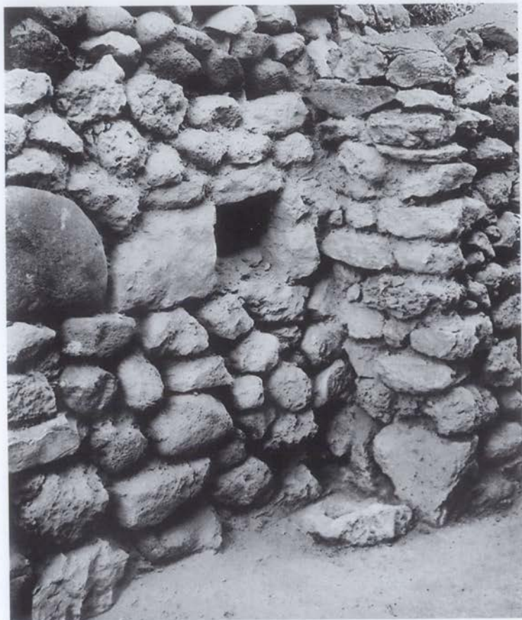
Εικ. 84. Έσωτερικό του δρόμου της πόλης: αριστερή πλευρά της πόλης με τὸ ἄνοιγμα γιὰ τὸν σύρτη· κάτω ὁ πέτρινος ἄρμος γιὰ τὸ σταθερὸ δοκάρι τῆς πόλης.
