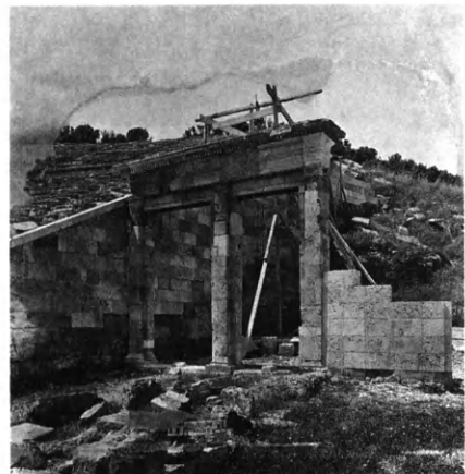
139. Πελοπόννησος. Ἐπίδαυρος. Τὸ ἱερό τοῦ Ἀσκληπιοῦ. Τὸ θέατρο. Ἡ πύλη τῆς δυτικῆς παρόδου κατὰ τὶς ἀναστηλωτικὲς ἐργασίες. (33×36)
