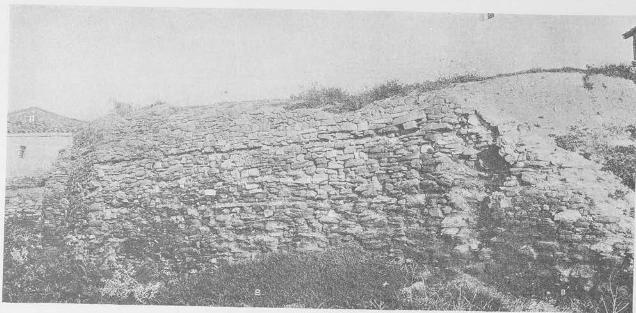
Εἰκὼν 115.—Τοίχος ἀσβεστοκτιστος τάφρου, ποιηθείσης ἐν ἔτει 1283 μ. Χρ.· B·B'—τὸ νῦν σφρζόμενον κατὰ τὸ βάθος τέμα αὐτῆς· Π—νεωτέρα πυριτιάτοθήκη, κτισθεῖσα ἐπὶ τοῦ τοίχου αὐτῆς.
