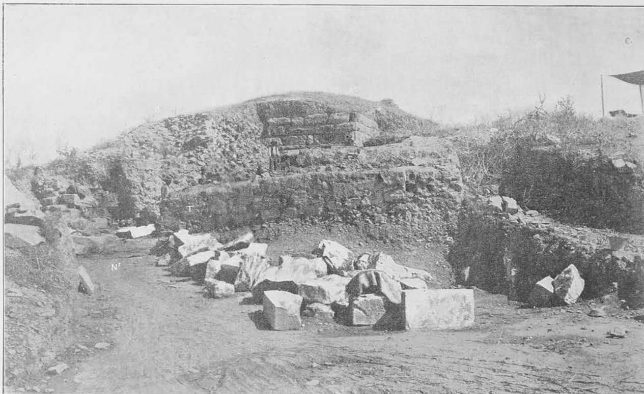
Είκων 23. Ό δεύτερος μέγας πύργος, ήδη άνασκαπόμενος. επ—ό έσωτερικός πύργος Δ—τό διακένον, μόπω έξερευνηθέν, πλήρες λίθων και στηλών· Ν-Ν'—ή Νοτία πλευρά τού έπηξημένου πύργου· Τ-Τ'—τό προστυτευτικόν τοιχώριον.
