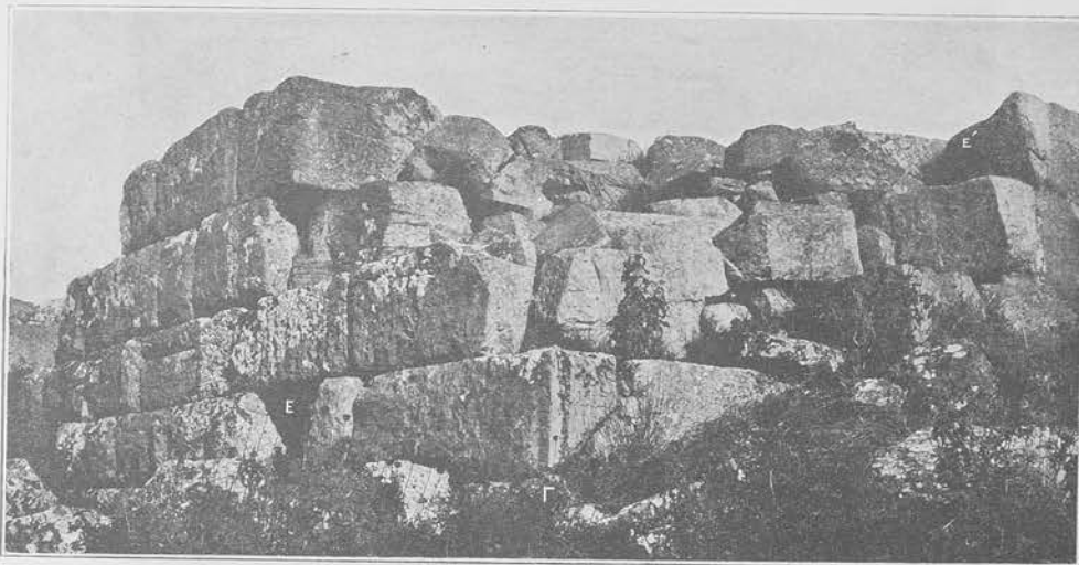
Εἰκὼν 154. Δεῖγμα τοῦ τρίτου ὄυθμοῦ τῆς ἐν Δημητριάδι τειχοδομίας, ἐξ ἑτέρου ὑπὲρ τὴν Φεραϊκὴν πύλην πύργου (τοῦ 200 ἢ 191 ἢ 185 ἢ 169 π. Χρ., ἔργον Φιλίππου τοῦ Ε' ἢ τοῦ Περσέως). Ε-Ε'—ἐπένδυσις ἐξωτερικῇ· Γ—κάθετος, βαθεῖα, λαξευτὴ γωνίωσις.
