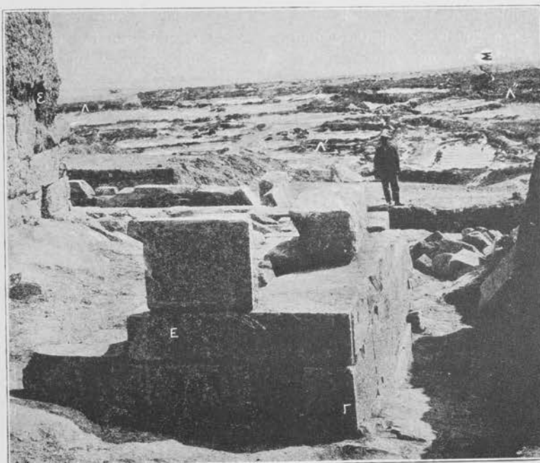
Εἰκὼν 151. Δεῖγμα τοῦ τρίτου ὄρθμου (169 π. Χρ., ἔργον τοῦ Περσέως) τῆς ἐν Δημητριάδι τειχοδομίας, ἐκ τῆς Νοτιοδυτικῆς γωνίας τοῦ ἐξωτερικοῦ πρώτου ἀνασσαφέντος μεγάλου πύργου. Ε—ὁ ἐξωτερικὸς πύργος· ε—ὁ ἐσωτερικὸς· Γ—κάθετος, βάθεια, λαξευτὴ γωνίωσις· Α—Α'—Α"—ὁ μέγας κλειστὸς πολεμικὸς λιμὴν τῆς Δημητριάδος· Σ—τὸ στόμιον αὐτοῦ.
