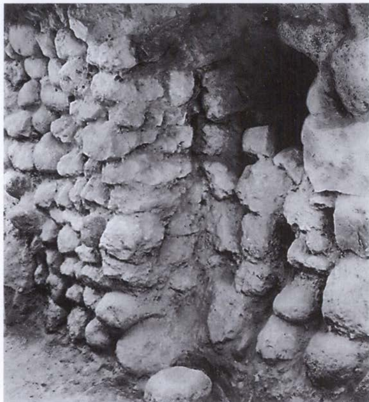
Abb. 85 Im Innern der Torgasse: mit rechtem Torkopf und Riegelöffnung, unten Torpfanne für den Drehbalken des Tores.
