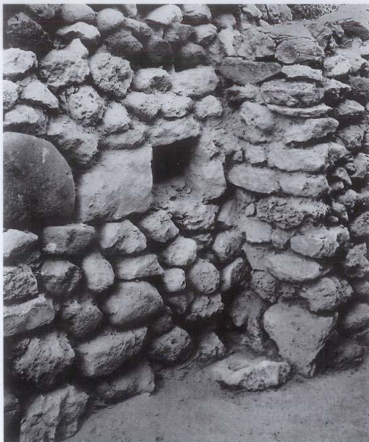
Abb. 84 Im Innern der Torgasse: linker Torkopf mit Riegelöffnung, unten Torpfanne für den Standbalken des Tores.
