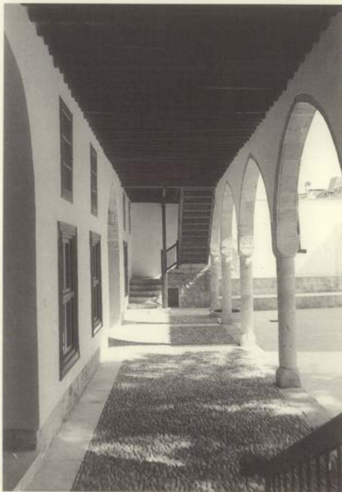
Ἡ λιθόστρωτη στοὰ στὴ βόρεια πλευρὰ τῆς ἐσωτερικῆς αὐλῆς τοῦ κτιρίου.
