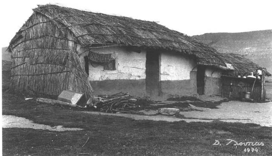
26. Σπίτι στὴν περιοχὴ Συκουρίου Θεσσαλίας ἀπὸ πλῆθρες καὶ λάσπη, μὲ ὀριζόντια ξύλα μέσα στὸ πάχος τοῦ τοίχου (φωτ. 1974).
