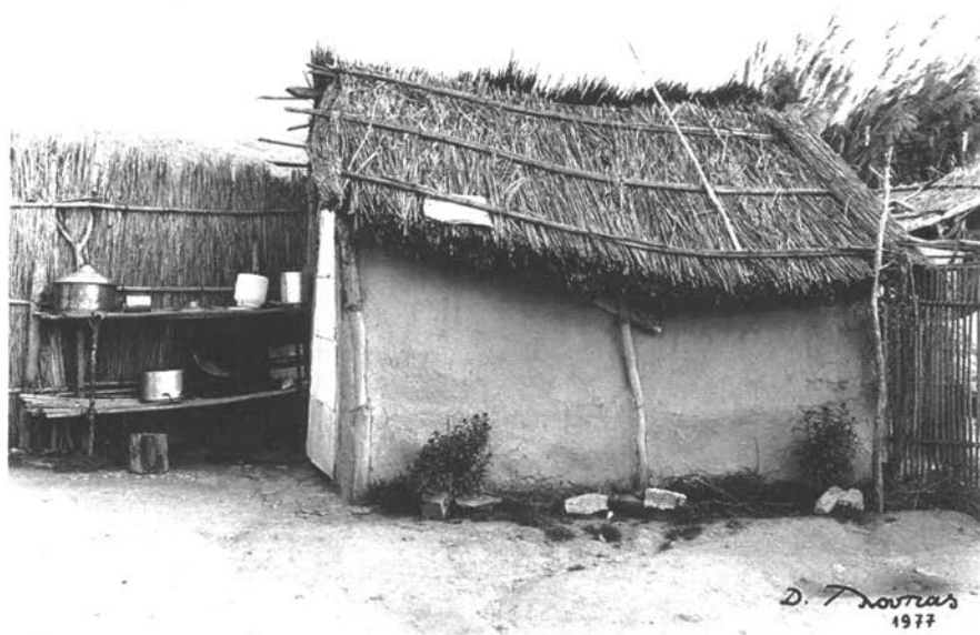
27. Σπίτι στην περιοχή Συκουρίου Θεσσαλίας με ἐξωτερικά στηρίγματα τῆς πλεκτῆς στέγης (φωτ. 1977).
