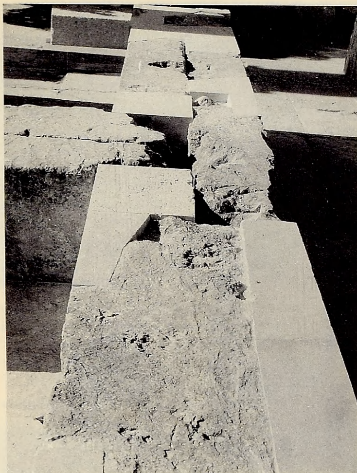
Τοίχος τοῦ σπηκαῦ μετὰ τὴν ἀναστίλωση τοῦ ναοῦ τῆς Ἀφραίας.
