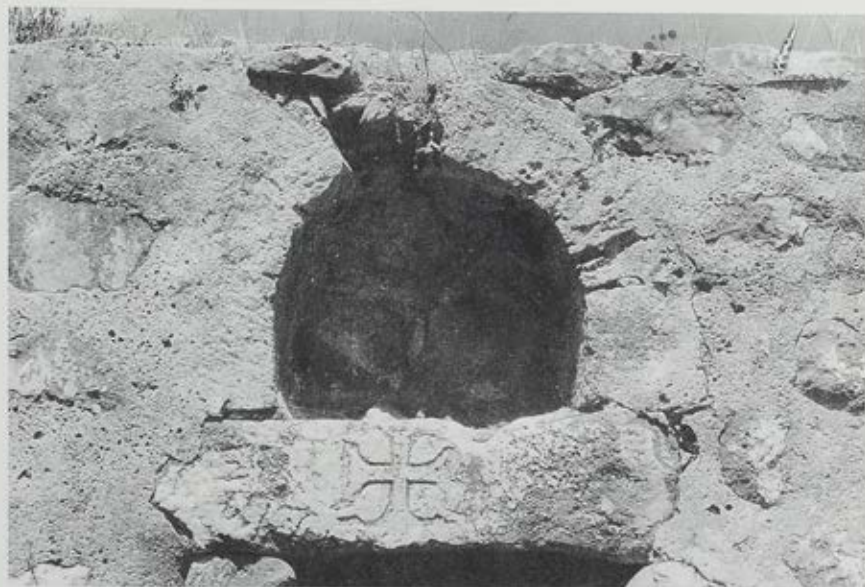
3 Πεταλόμορφο ἀνακουφιστικό τόξο τῆς φραγμένης Ν θύρας.
