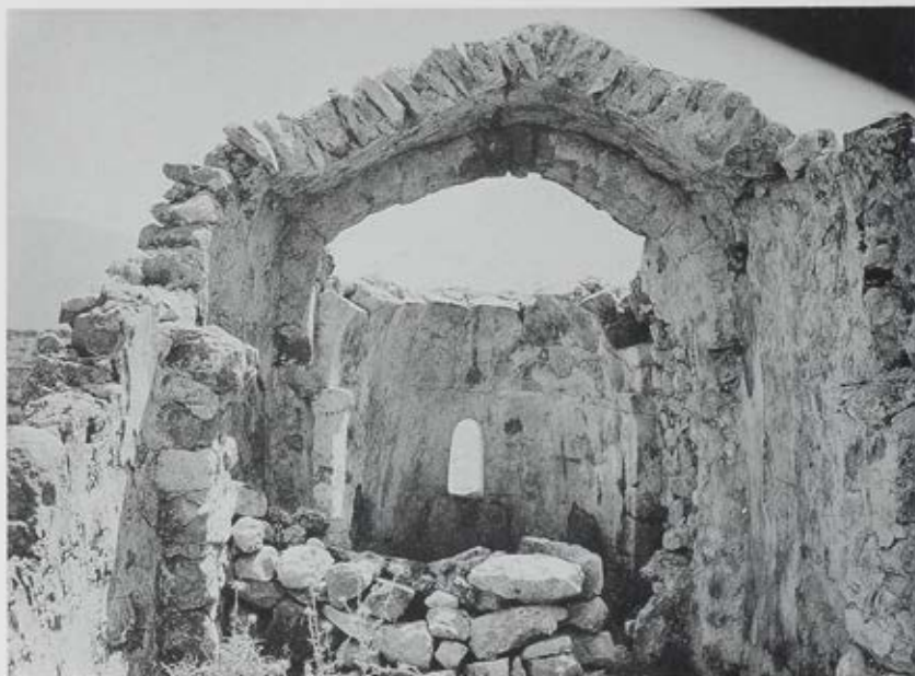
5 Τò εσωτερικό του Α τμήματος της εκκλησίας.
