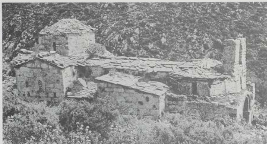
1 Ἡ Β πλευρά τοῦ Ἀι-Στρατήγου Μπουλαριῶν πρὸ τῶν ἐργασιῶν συντηρήσεως.
