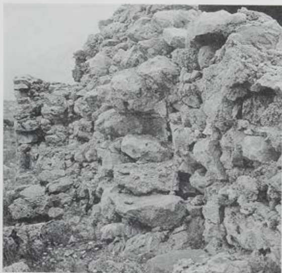
4 Τμήμα του Β τοίχου.
