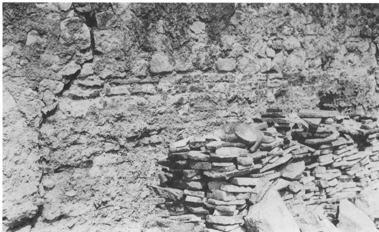
Βαλανεῖο. α) Terpidarium III (χώρος 5). Νότιος τοῖχος (βόρεια ὄψη). β) Χῶρος 11. Νότιος τοῖχος (νότια ὄψη).
