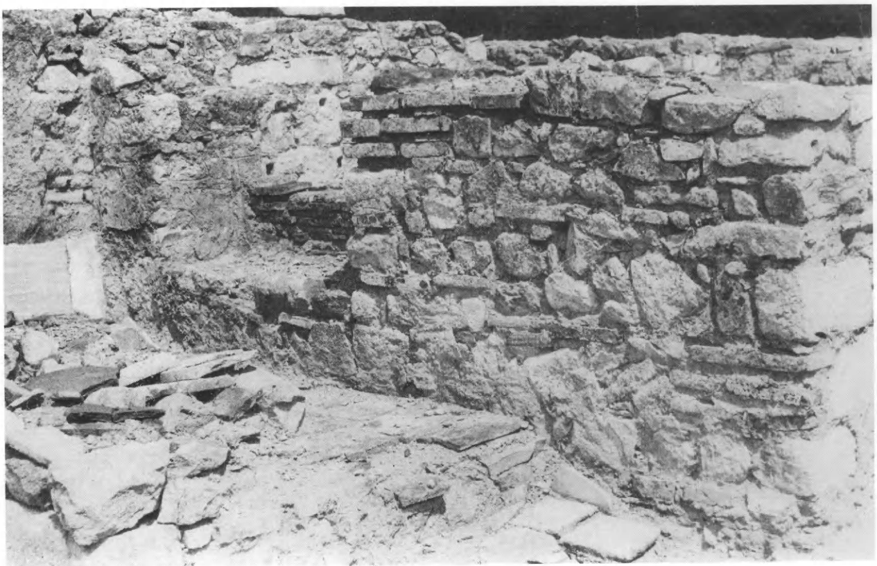
Ὁκτάγωνο. Βαπτιστήριο. α) Τμήμα τοῦ δυτικοῦ τοίχου τοῦ Φωτιστηρίου. β) «Κατηγουμενεῖο», ὁ ἀνατολικὸς τοίχος μετὰ τὴ βόρεια «ἐξέδρα».
