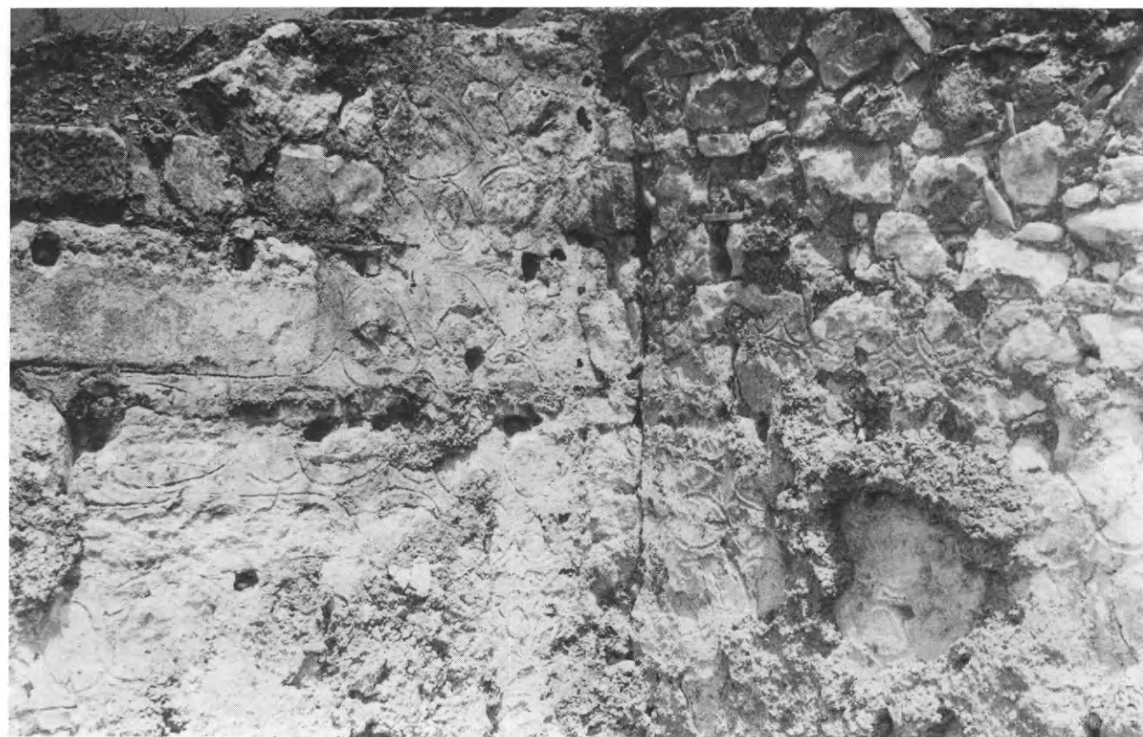
Ἐκτάγωνο. Βαπτιστήριο. α) Φωτιστήριο. Βόρειος τοίχος (δυτικό του τμήμα). β) Βόρειος τοίχος (δεξιὰ) καὶ ΒΔ πεσσὸς (ἀριστερά).
