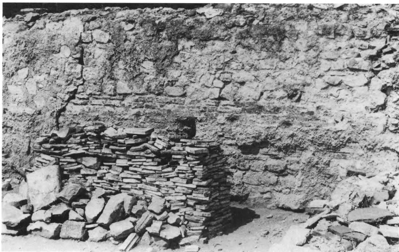
Ἐκτάγωνο. Βαπτιστήριο. α) Ὁ ἀνατολικὸς τοῖχος τοῦ Ἐποδυτηρίου μετὰ τὸ ἐρμάριο. β) «Κατηχομενεῖο». Ὁ βόρειος τοῖχος. Ἄριστερά τὸ ἐξ ἐπισκευῆς τμήμα.
