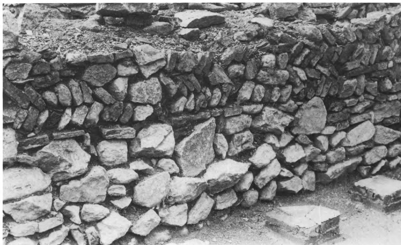
Βαλανείο. α) Χώρος 11. Άγωγοι αποχέτευσης. β) Χώρος 4. Νότιος τοίχος.
